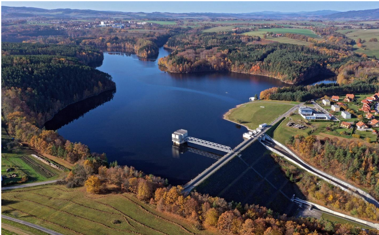
Popis obrázku: Hrázová část římovské nádrže, která byla jednou ze zkoumaných přehrad.
