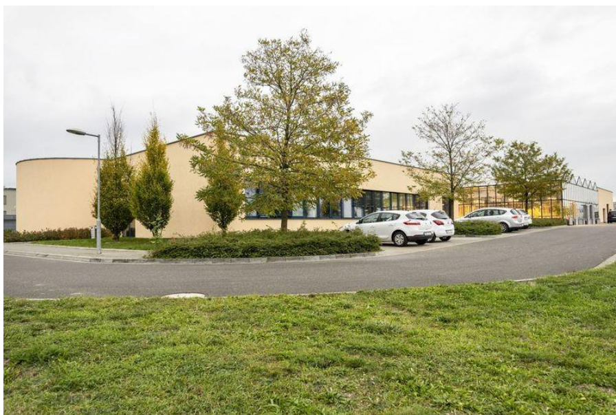
Budova olomouckého pracoviště ÚEB
