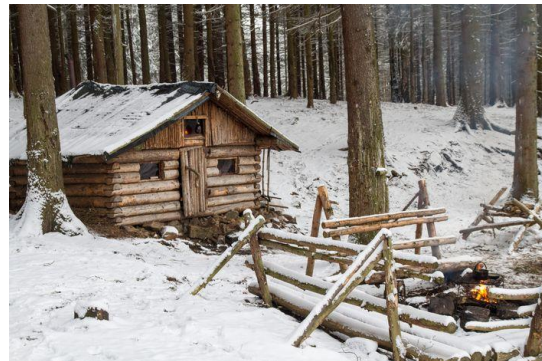
S jistým zpožděním za tradiční obytnou lidovou architekturou se pozornosti dočkaly také různé typy novějších improvizovaných staveb obecně označované pojmem „neformální architektura“. Trampský sroubek White River vystavěný roku 1989, Brdy–Hřebený. FOTO: Jan Pohunek
