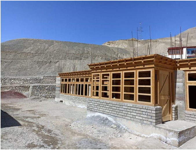
Budova prvního patra nové školní laboratoře s osazeným okenními rámy FOTO: Brontosauři v Himálajích
